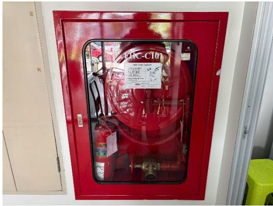
รูปที่ 7 ตู้สายฉีดน้ำดับเพลิง (Fire Hose Cabinet)
